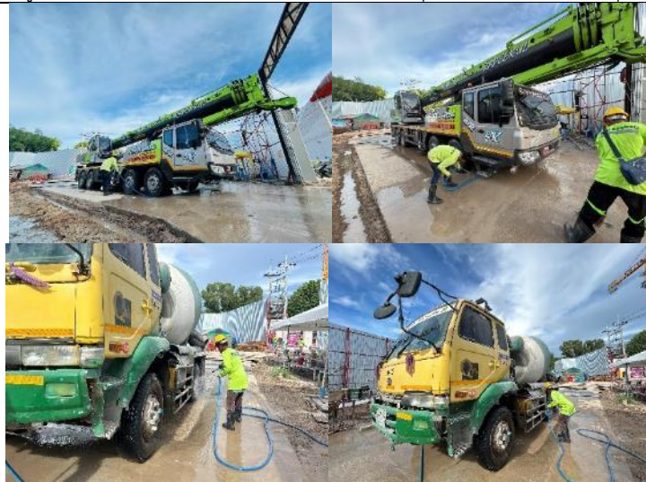
รูปที่ ผ7.18 การล้างล้อรถก่อนออกนอกพื้นที่โครงการ (ในช่วงที่มีการก่อสร้าง)
