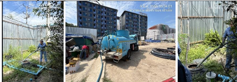
รูปที่ ผ7.57 การสูบล้างปลั๊กอุดหูจากกระบอกน้ำเสีย (ในช่วงที่มีการก่อสร้าง)
