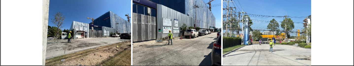
รูปที่ ๗7.10 เจ้าหน้าที่คอยพรมน้ำบริเวณพื้นที่ก่อสร้าง หรือบริเวณที่ทำให้เกิดฝุ่น (ในช่วงที่มีการก่อสร้าง)
