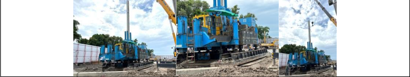
รูปที่ ผ7.20 ใช้เสาเข็มแบบกด (Jack In Pile) (ในช่วงที่มีการก่อสร้าง)
